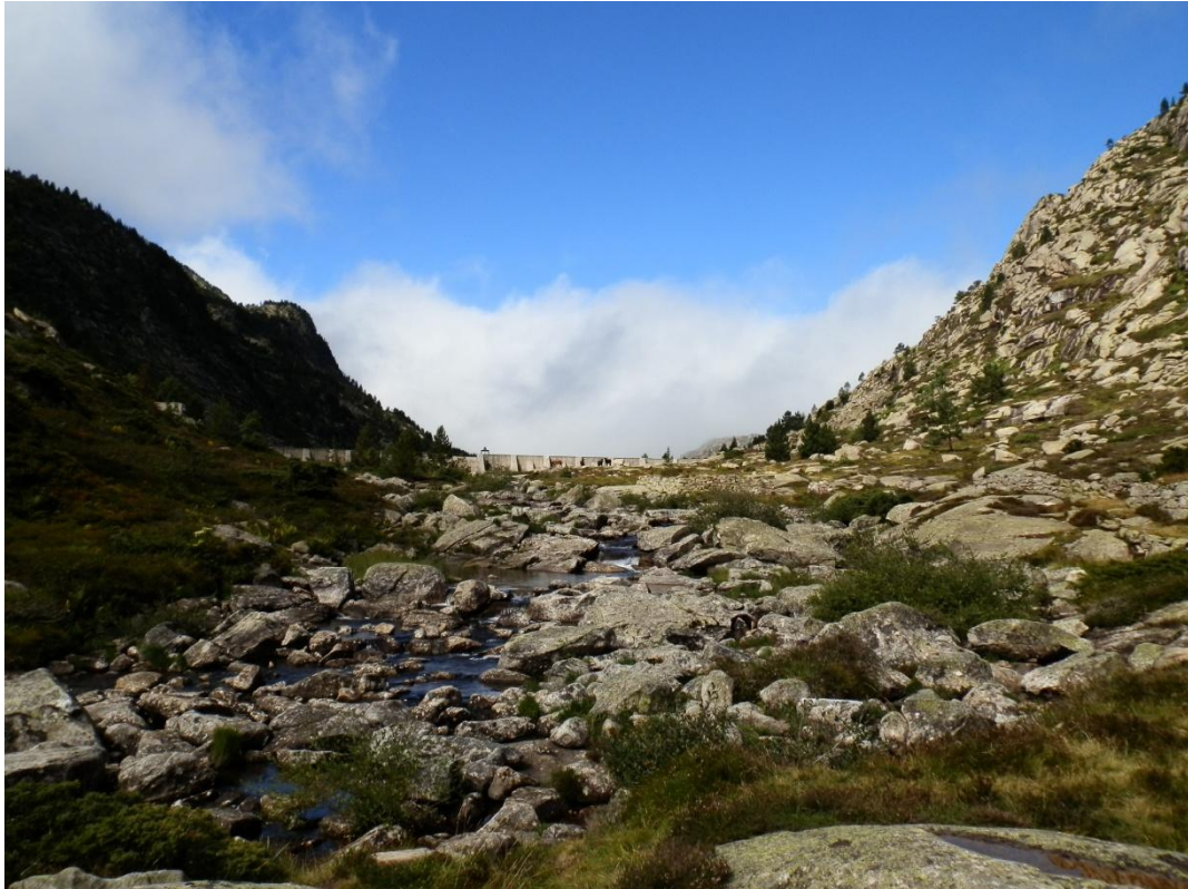
Barrage sur l'étang Majeur de Bassiès – Photo J. Garcia/CBNPMP
