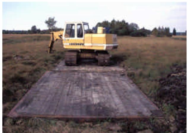
**Photo 18** : plateaux spécialement conçus pour utilisation d'engins Lourds sur des sols à très faible portance.
