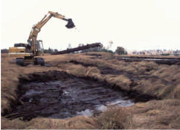
**Photo 19** : pelleteuse soulevant un plateau pour se déplacer
