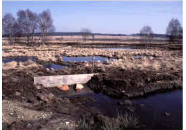
**Photo 22** : exutoire muni de deux tuyaux coudés à leur extrémité amont. En faisant pivoter la partie coudée, on peut régler la profondeur d'eau dans le bassin.
