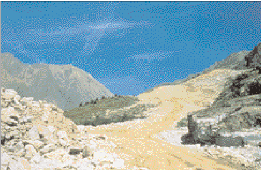
La piste après travaux de terrassement.
