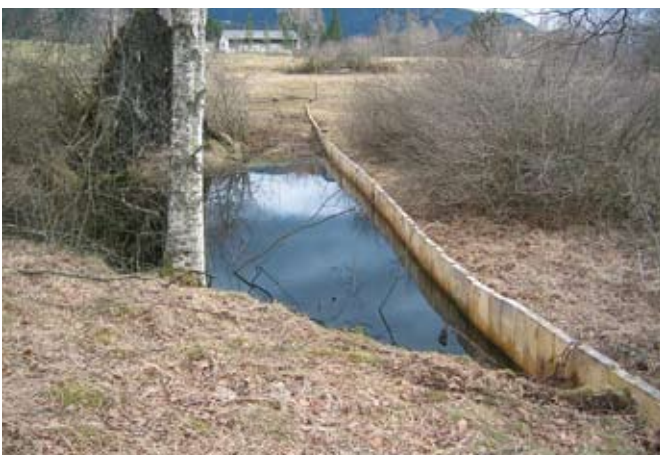
Fig.104 Palissade implantée, avant recouvrement avec de la tourbe, Walchwil (ZG), tourbière de Früebüelmoos
