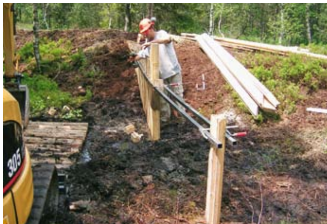
Fig.102 Profils métalliques servant de guide pour l'enfoncement des planches
