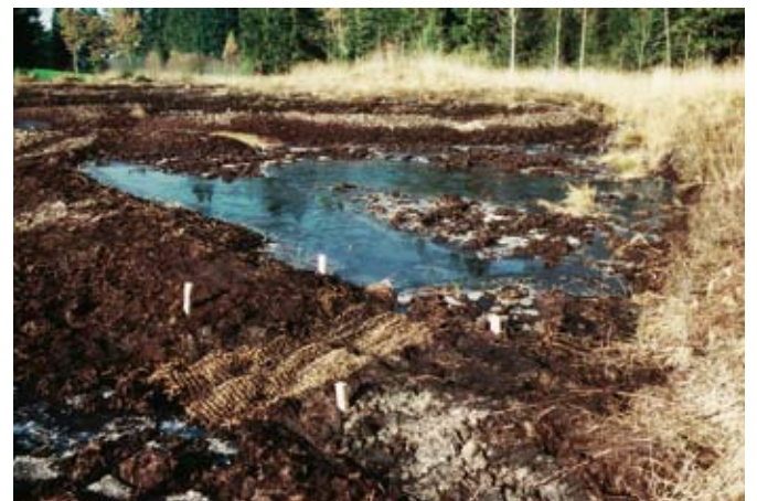
Fig. 56 Trop-plein aménagé sur digue de tourbe avec natte de coco, Eggiwil (BE), réserve naturelle cantonale du Steinmösli
