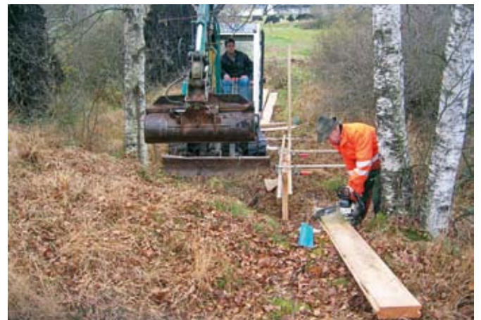
Fig.103 Sciage des planches en biseau à la tronçonneuse
