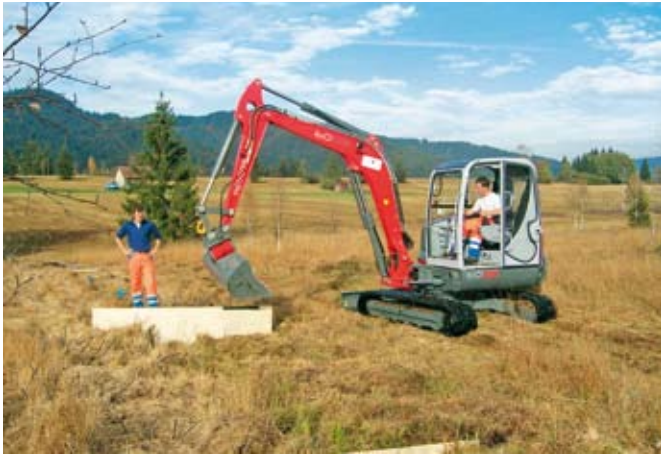
Fig. 88 Pose de panneaux en commençant par l'amont de la rigole
