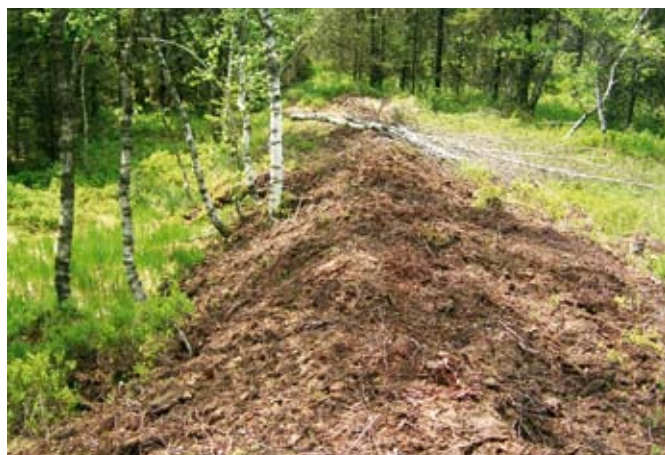
Fig. 106 Palissade de bois recouverte de tourbe, Le Cerneux-Péquignot (NE), Marais des Saignes-Jeanne
