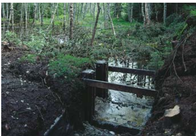
Fig. 108 Régulation hydrique contrôlée par un caisson en bois; les planchettes placées transversalement à l'axe de l'écoulement permettent de fixer le seuil d'inondation derrière l'ouvrage; selon l'évolution de la végétation, ce seuil peut progressivement être relevé. Saicourt (BE), réserve naturelle cantonale de Bellelay
