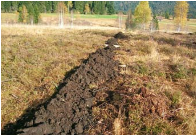
Fig. 90 Recouvrement des panneaux avec de la tourbe
