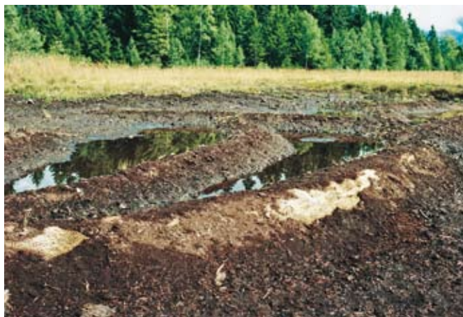
Fig. 57 Traces d’érosion sur une digue, Eggwil (BE), réserve naturelle cantonale du Steinmösli
