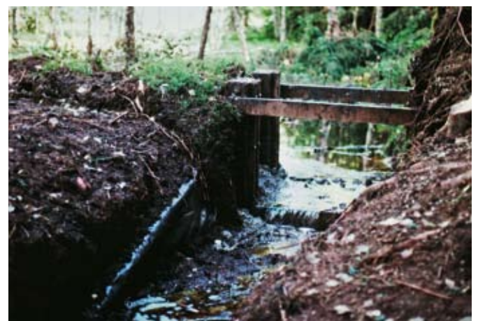
Fig. 108 Régulation hydrique contrôlée par un caisson en bois; les planchettes placées transversalement à l'axe de l'écoulement permettent de fixer le seuil d'inondation derrière l'ouvrage; selon l'évolution de la végétation, ce seuil peut progressivement être relevé. Saicourt (BE), réserve naturelle cantonale de Bellelay
