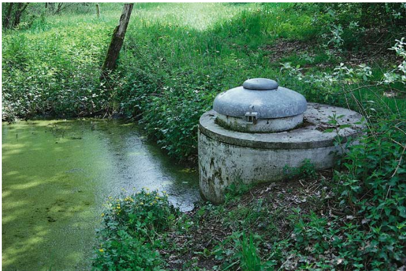
Fig. 117 Régulation hydrique contrôlée par une vanne installée dans une chambre de ciment; selon l'évolution de la végétation, ce seuil peut progressivement être relevé; l'eau est évacuée vers un ruisseau en aval; Rifferswil/Kappel am Albis (ZH), tourbière de Hagenmoos
