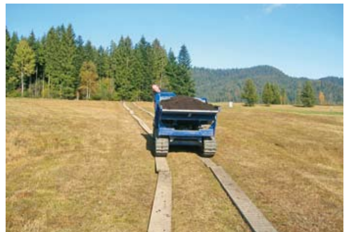
Fig. 16 Passerelle de planches pour véhicule
