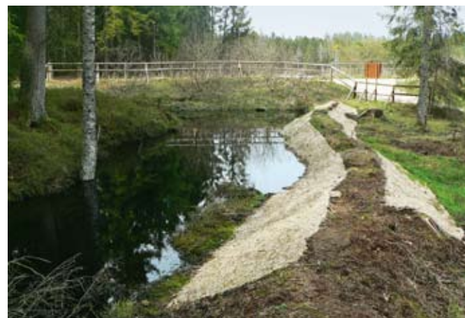
Fig. 107 Protection de la digue contre l'érosion à l'aide d'une natte de paille tissée, Saignelégier (JU), Etang de la Gruère
