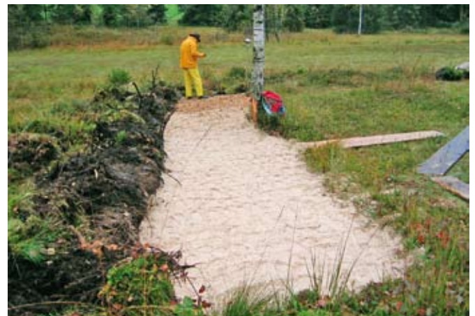
Fig. 93 Variante: comblement de la rigole avec de la sciure («méthode zougoise»)
