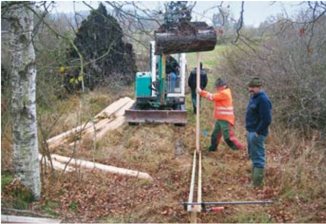
Fig.101 Enfoncement des planches à la rétropelleuse
