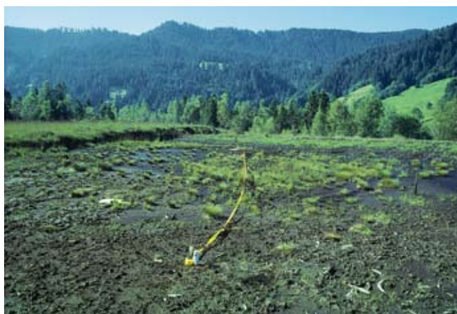
Fig. 34 Marquage du parcours de la rétropelleuse
