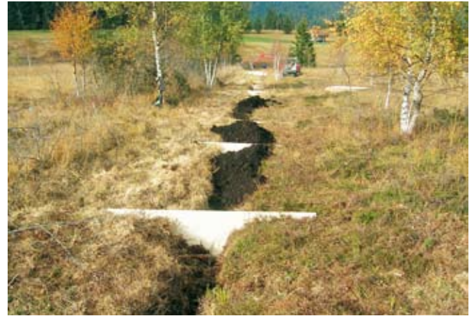
Fig. 89 Rigole barrée par des panneaux à intervalles réguliers et comblement avec de la tourbe
