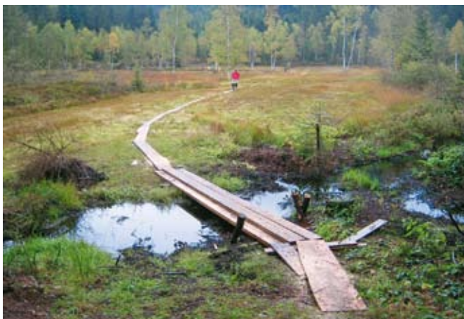
Fig. 15 Passerelle de planches
