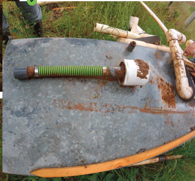
Installation d'un skimmer au sein d'un bassin de décantation provisoire.
