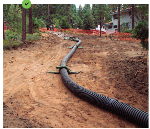
Gaine HDPP contournant une zone de chantier active.
