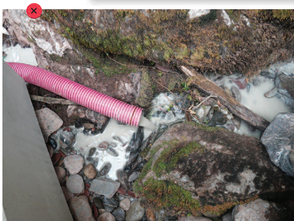
Rejet de laitance béton en milieu naturel.
