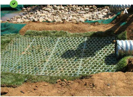
A, B - Protection d'un point de rejet à l'aide d'un tapis laminaire PEHD. Le tapis favorise l'étalement de la lame d'eau et dissipe l'énergie hydraulique. Les faibles turbulences à la surface de l'eau permettent la reprise végétale, protégeant d'autant plus efficacement les sols contre l'érosion.
