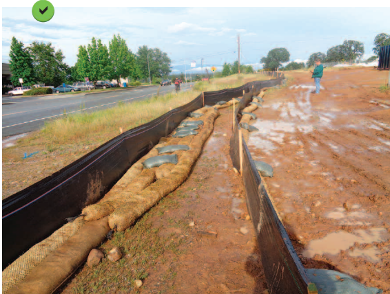
Double barrières de rétention installées à la périphérie de l'emprise du chantier et conjuguées à des boudins en fibres de paille maintenus au sol par des sacs de graviers.
