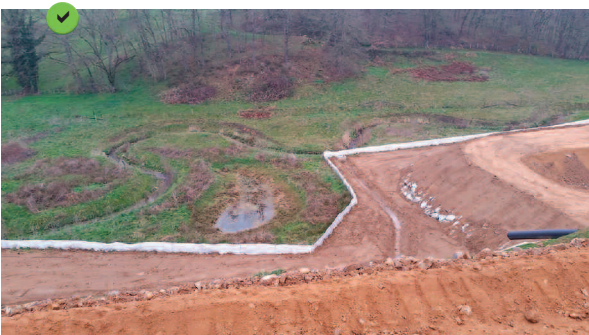
Barrière de rétention longeant un cours d'eau.
