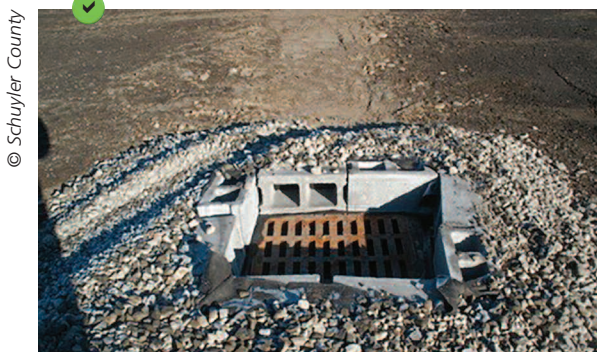
Type 3 : enrochement drainant qui permet une rétention de l'eau chargée et un écoulement réduit dans le réseau. Les deux dispositifs sont construits avec parpaings à l'intérieur et un merlon en graviers autour.
