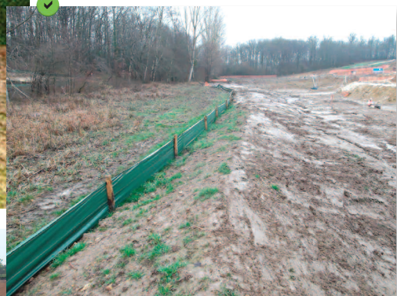
Merlon en bas de pente, associé à une barrière de rétention provisoire en géomembrane et équipé d'une surverse (dans le prolongement de la géomembrane). Il protège une zone humide et un cours d'eau longeant le chantier.
