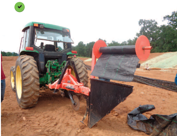
Dispositif d'installation automatique des barrières de rétention.
