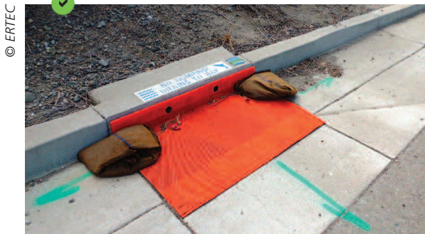
Type 2 : cadre filtrant de type extérieur. En PEHD, il est réutilisable et adaptable à plusieurs modèles d'avaloir.
