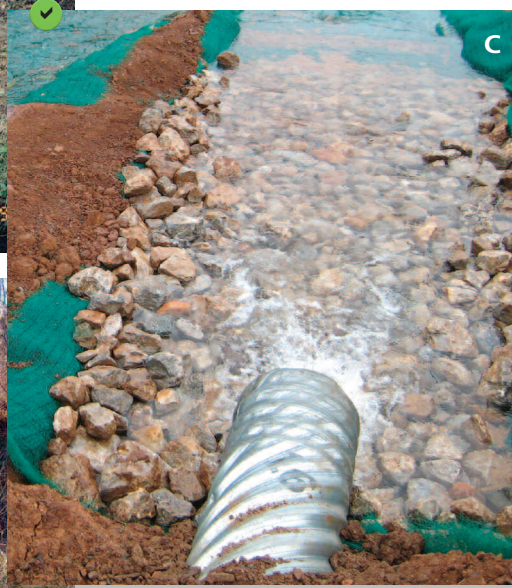
A, B, C - Dispositifs temporaires de protection des points de rejet à l'aide de tas de graviers et de blocs installés en amont du lit mouillé des cours d'eau. Attention toutefois à ne pas dégrader les berges.
