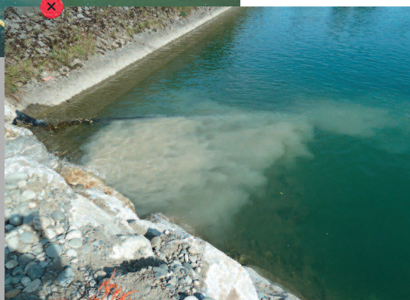
Lessivage de la laitance d'un coffrage suite à un arrêt trop précoce des pompes et pompage incomplet de la laitance dans le bac de traitement.
