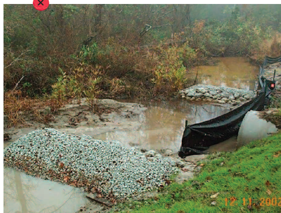
Double barrières de rétention installées à la périphérie de l'emprise du chantier et conjuguées à des boudins en fibres de paille maintenus au sol par des sacs de graviers.
