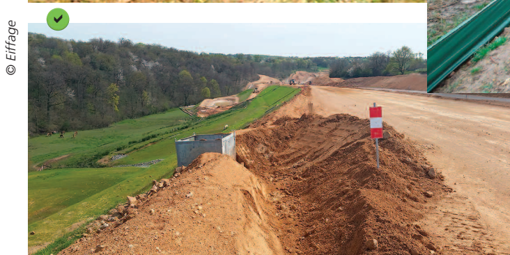
Fossé de collecte des écoulements superficiels.
