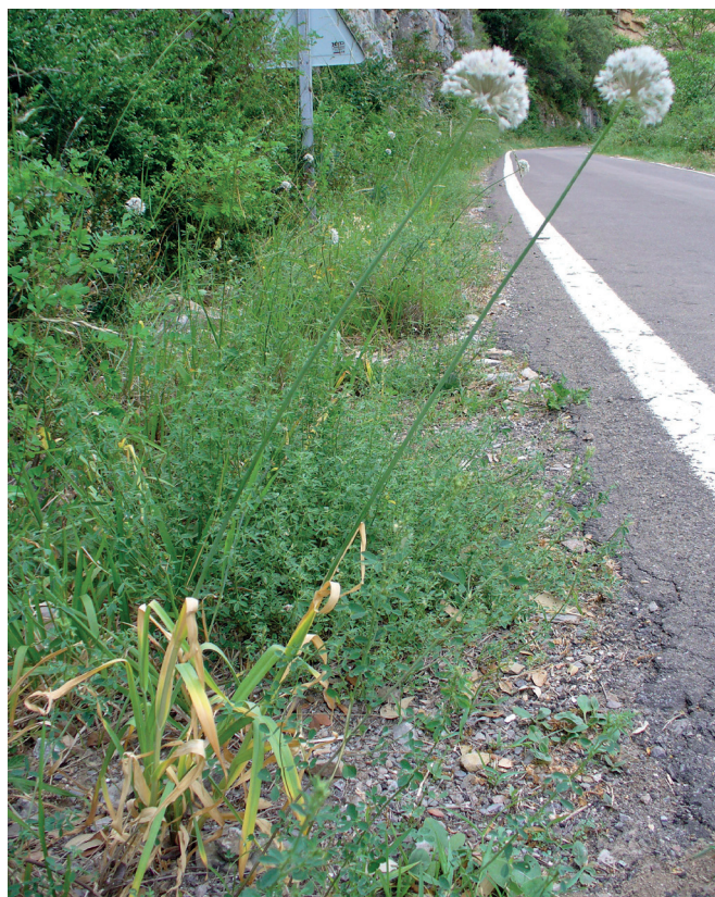
Fig. 3. Cuneta de la foz de Biniés después de las obras de 2008.
