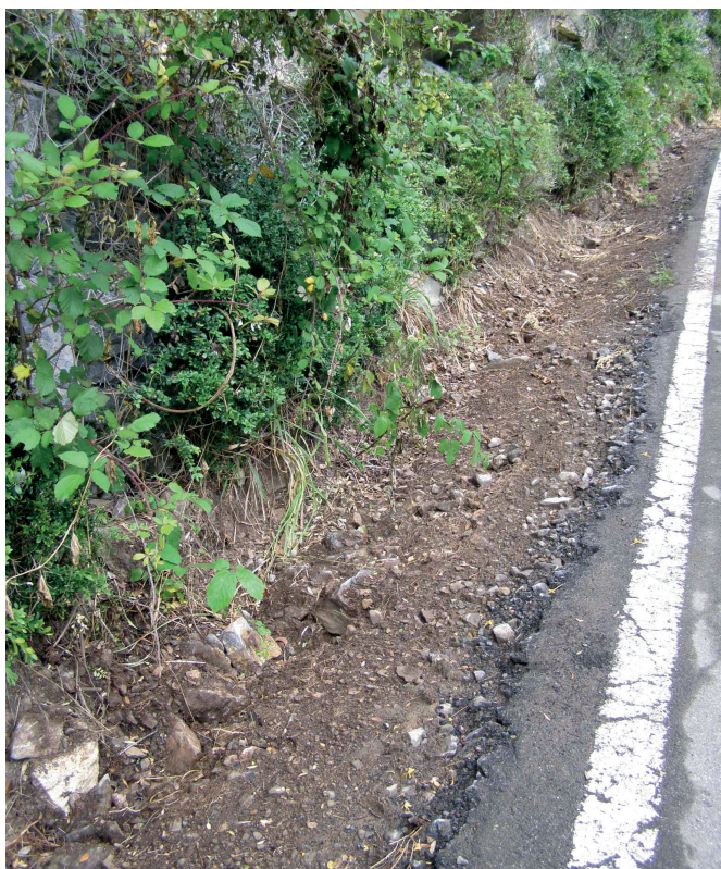
Fig. 2. Cuneta de la foz de Biniés antes de las obras, con Allium pyrenaicum .
