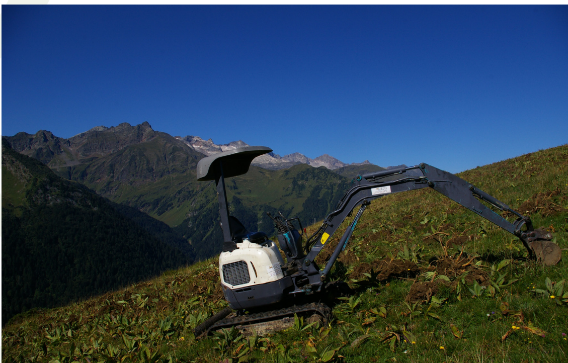
Figure 11 : Fourche mécanique sur une estive pyrénéenne. © Raphaële Garreta/CBNPMP
