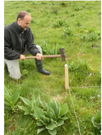
Figure 3 : pose d'un piquet bois au merlin
