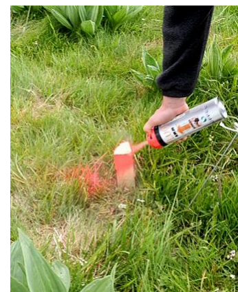
Figure 4 : repérage à la bombe de marquage fluo des piquets bois plantés
