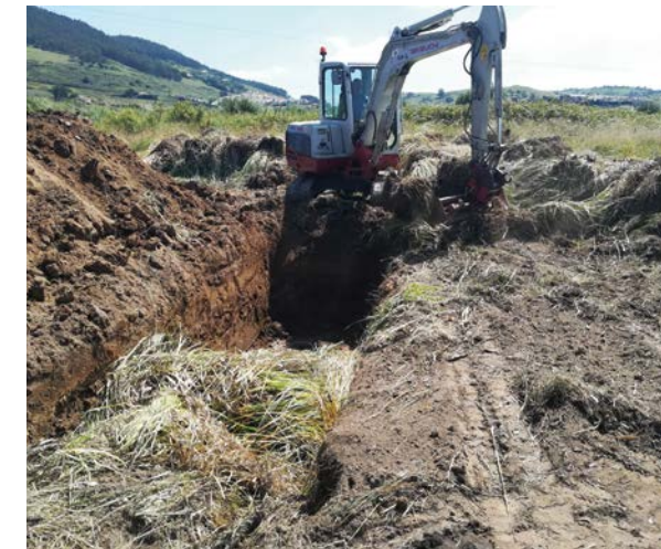
L'élimination de Cortaderia produit une importante quantité de biomasse, l'enfouissement des déchets facilite une restauration rapide du terrain grâce à l'ensemencement ou la plantation
