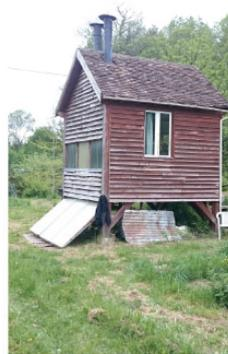
Séchoir solaire avec prise d'air extérieur (à gauche)
