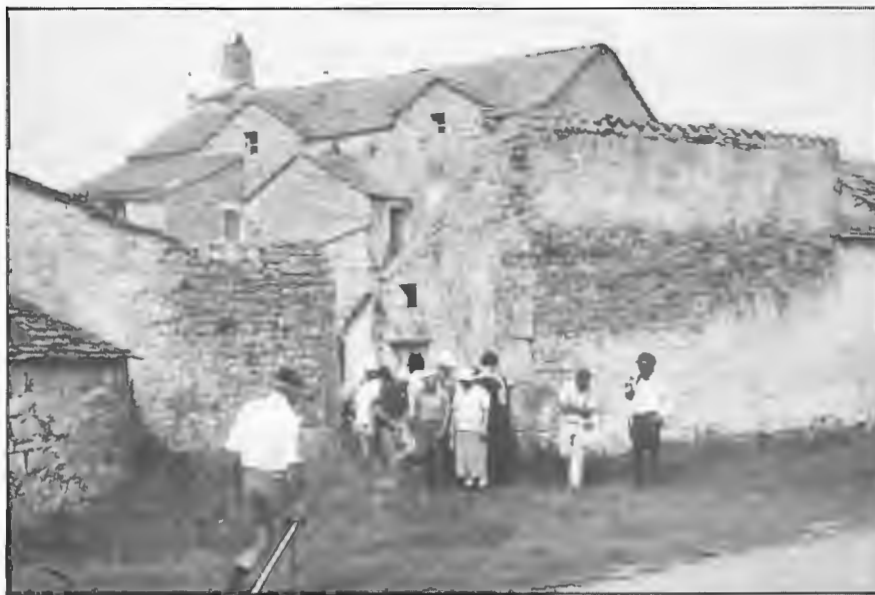
Saint-Martin du Larzac. 5/7/1982.(Photo G. AYMONTIN)
