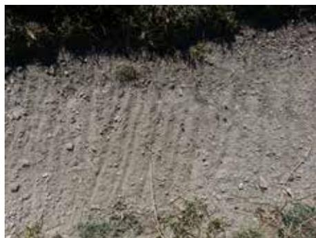
Figure 18 : Griffage du sol perpendiculairement au sens de la pente.
