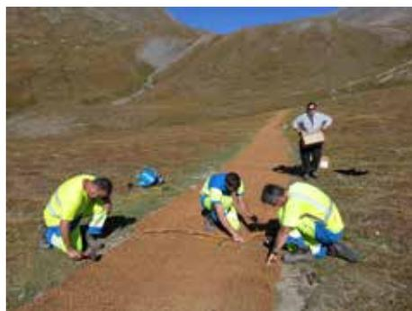
Figure 19 : Pose du géotextile
