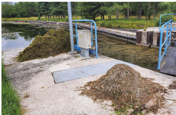
Figure 5-59 : Stockage intermédiaire, ressuyages végétaux aquatiques (VNF)
