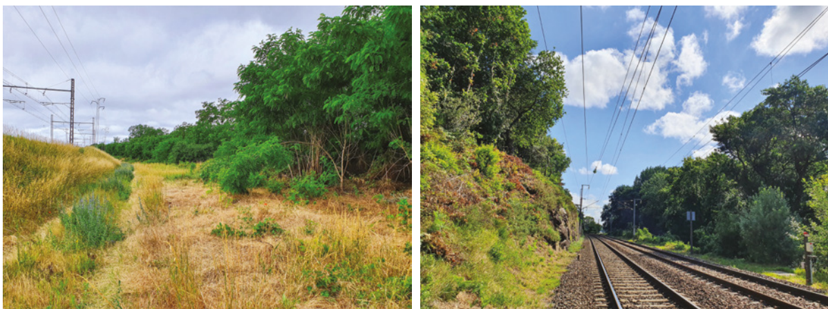
Figure 3-16 : Dépendances ferroviaires (SNCF Réseau)
