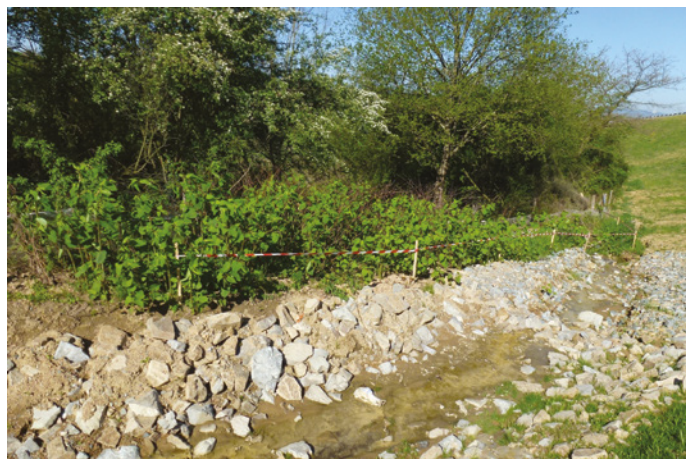
Figure 4-8 : Phase travaux : balisage (J. Biaunier/Cerema)
