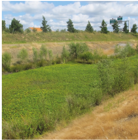
Figure 3-26 : Invasion de jussies dans un bassin d'assainissement (Cerema)
