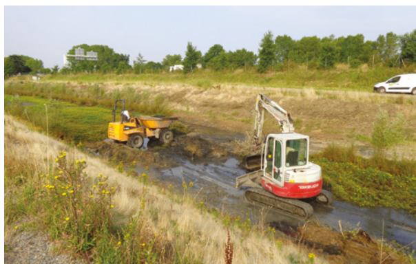
Figure 5-56 : Gestion par exportation de la jussie dans un bassin d'assainissement routier (Cerema)
