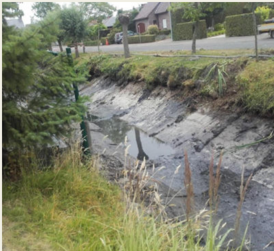
Fig 109. Un curage a été effectué sur l'entièreté du site envahi. Photo : Provincie Oost-Vlaanderen dienst Integraal Waterbeleid
