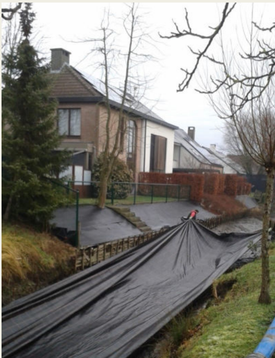
Fig 111. Une toile géotextile a été installée afin de priver l'espèce de lumière pendant plusieurs années. Photo: Provincie Oost-Vlaanderen dienst Integraal Waterbeleid
