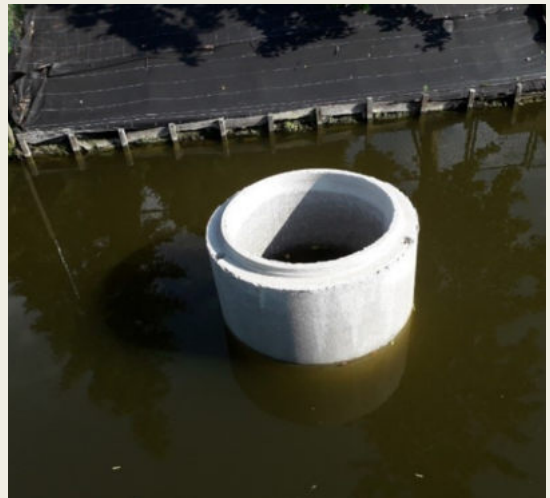
Fig 112. Les anneaux de béton permettent de vérifier l'efficacité de la gestion sans pour autant retirer l'entièreté de la toile géotextile. Photo: Provincie Oost-Vlaanderen dienst Integraal Waterbeleid
