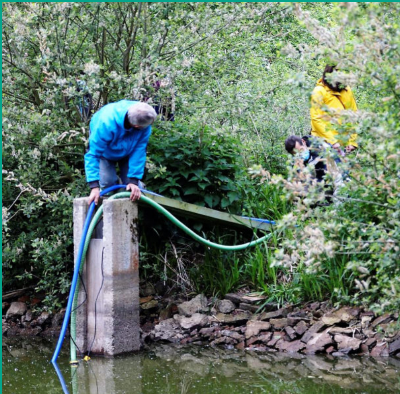
Fig 22. Une diminution du niveau d'eau permettra aux opérateurs de marcher et de se déplacer facilement. Photo : Marie Patinet
