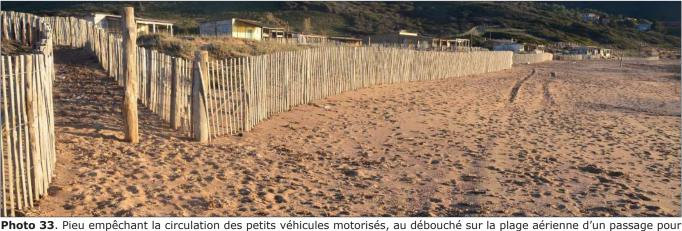
**Photo 33.** Pieu empêchant la circulation des petits véhicules motorisés, au débouché sur la plage aérienne d'un passage pour piétons entre les ganivelles (20 décembre 2017).
