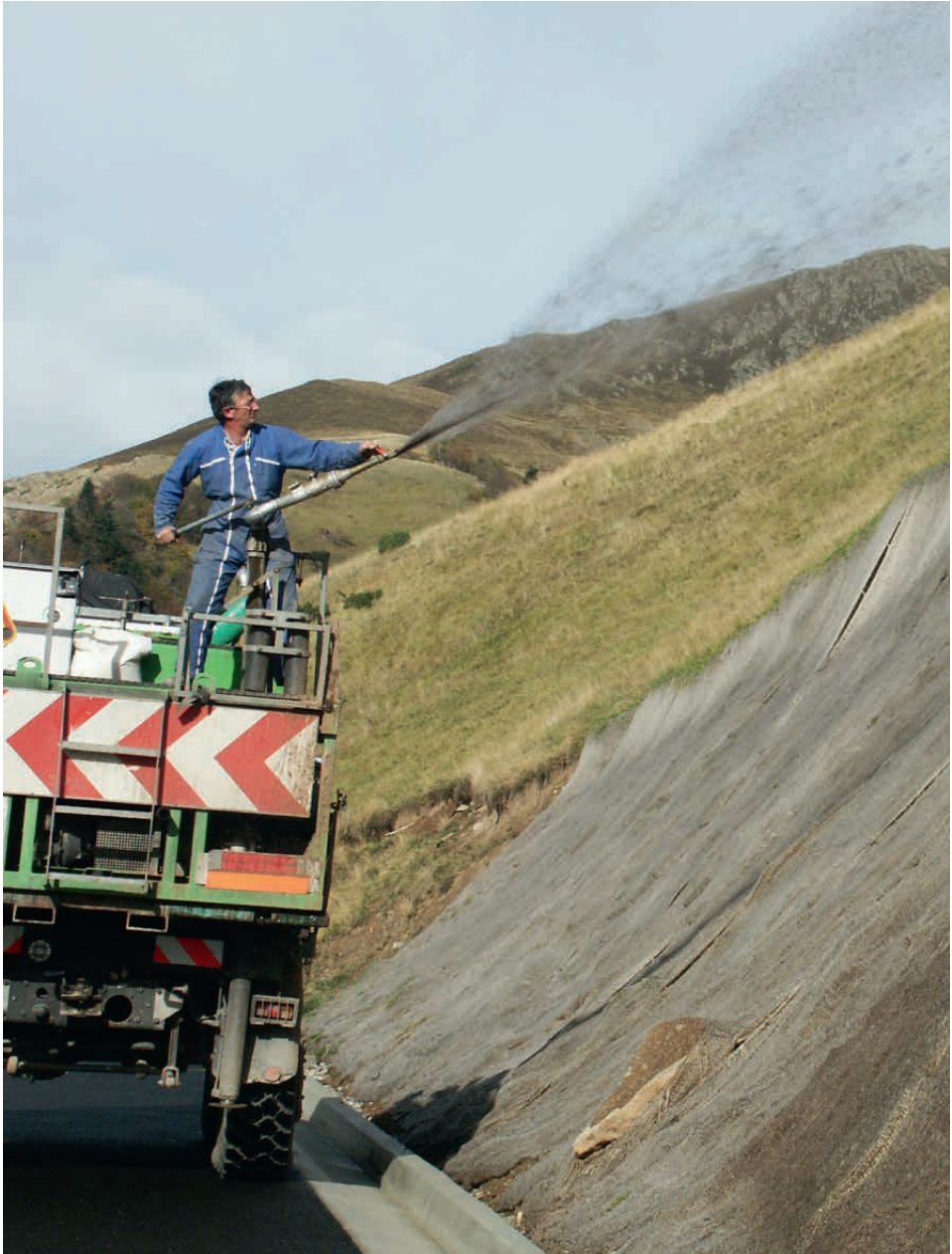
Eau, semences, fertilisants et agents fixateurs sont mêlés pour être projetés à l'hydroseeder sur la pente à revégétaliser.
