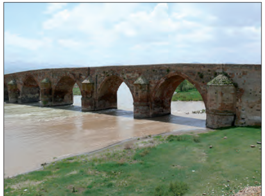
Figure 6 - Pont de Köprülölü (Erzurum), 22 mai 2009.
