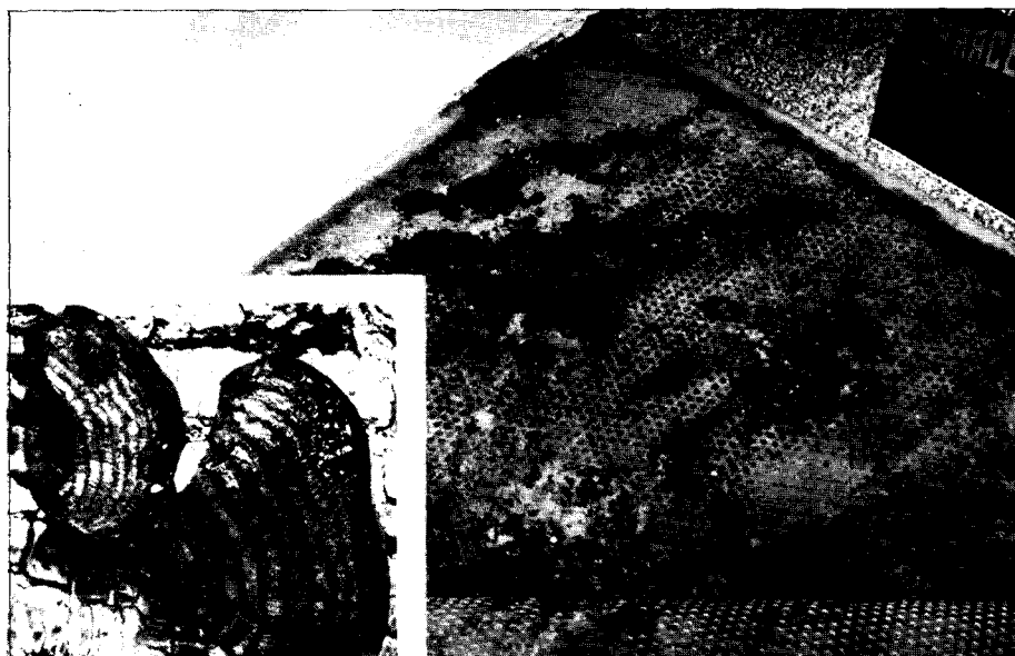
Photographie n° 4 : Gros plan sur les dégâts causés par le Daldinia : en haut au milieu, une fructification est en formation. En médaillon, à gauche : les zones concentriques et brillantes du Daldinia ne laissent aucun doute sur l'identification de "l'envahisseur" !
