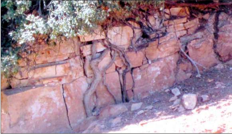
Photo 3 - Coupe verticale du substrat (ensemble sol et substratum géologique) à la faveur du talus bordant la RN 13 aux abords de la cluse d'Aït-Oufella sur le revers méridional du Moyen-Atlas central montrant comment l'yeuse met en place à la fois un système racinaire profond et un autre, superficiel et traçant. On remarquera le pendage conforme des bancs de calcaires durs imposant un enracinement restant en grande partie près de la surface du substrat. Toutefois, la présence de fissures larges de quelques millimètres, plus ou moins verticales et remplies d'un résidu terreux assure au système racinaire du chêne vert un certain développement en profondeur.
