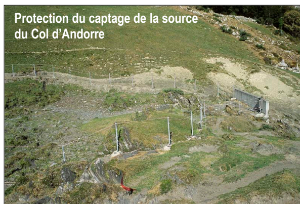
© Photo : I.BASSI / ONF 65 – 2003 / 2004
