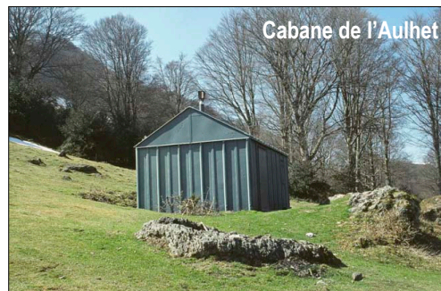
© Photo : I. BASSI / ONF 65 – 2003
