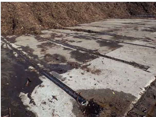
Figure 4 : drains (ventilation forcée)
