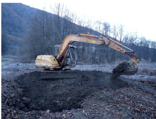
Figure 8 : extraction des rhizomes à la pelleteuse
