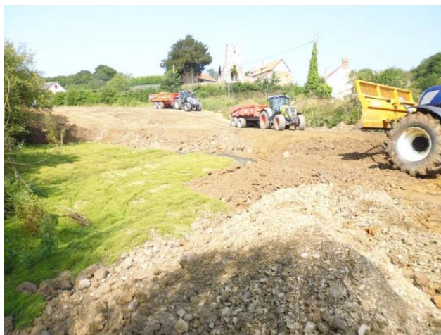
Figure 20 : Travaux de comblement d'un bras mort de la Vire, Basse-Normandie. © CEN Basse-Normandie
