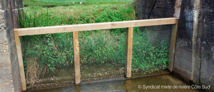
Barrage filtrant permettant d'éviter la dissémination de boutures de plantes aux tiges fragiles
