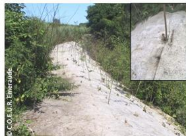
Zone bâchée avec boutures de Saules plantées
