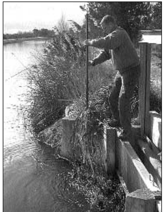
Nettoyage de la grille d'écluse (photo : RN Cousseau)
