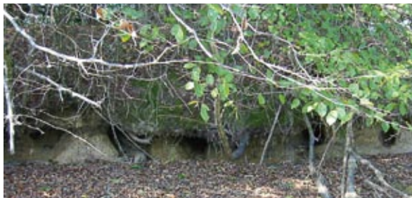
Galeries creusées par les ragondins dans une digue.
