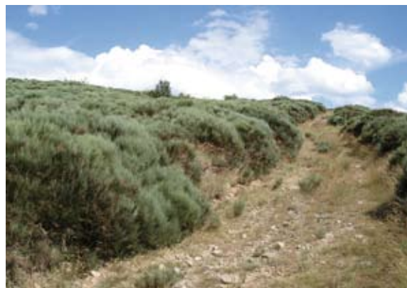
Réfection d'une piste d'accès.
