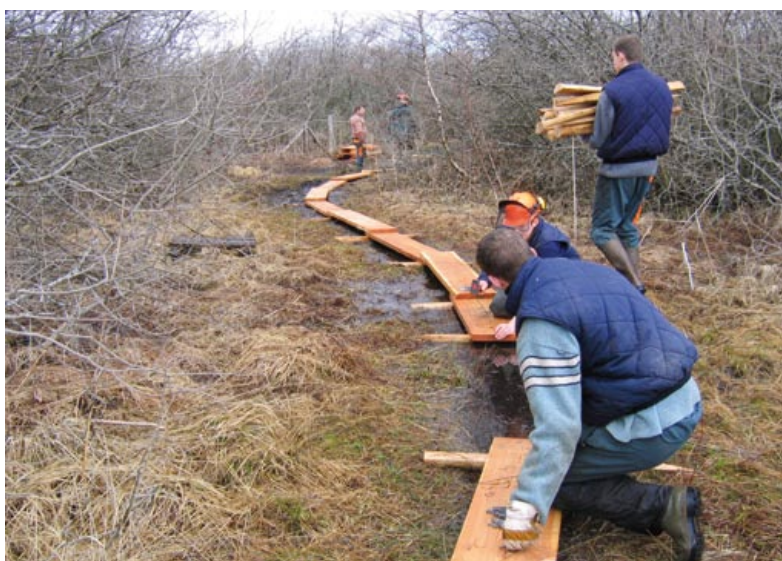
La pose d'un sentier sur pilotis dans le marais de Vaux (Ain).
