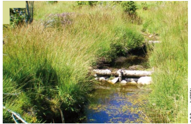
Pose de seuil sur la tourbière de la Verrerie (Ardèche).
