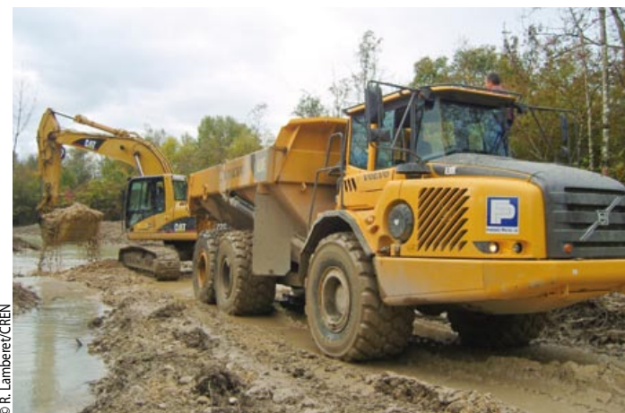
Extraction et transport des galets.
