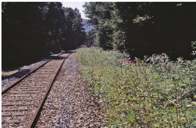
Fossé le long de la voie ferrée à Sermamagny - HENNEQUIN C.
