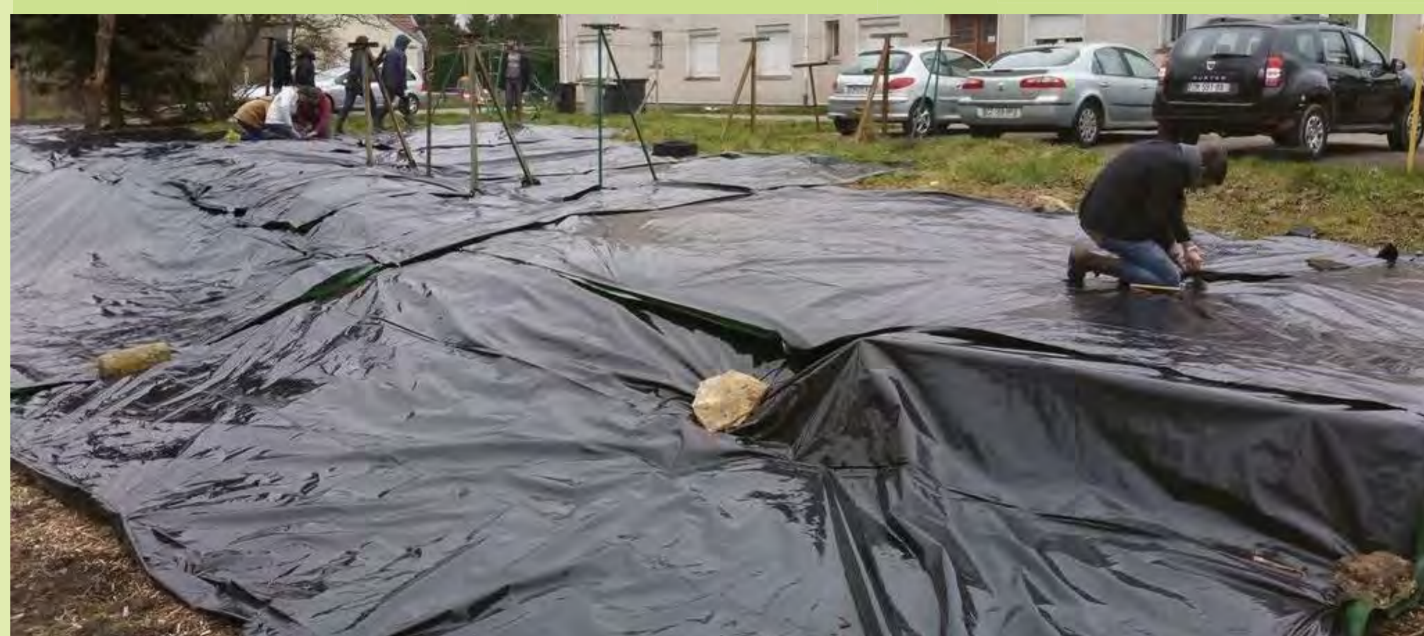
Exemple de bâchage réalisé par les étudiants à Belleville (54) en Mars 2016
