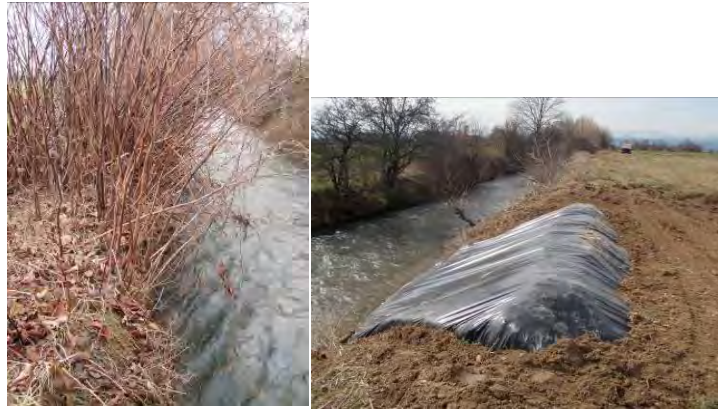
Figure 15 : Bâchage aux Collières à Epinouze [10]
