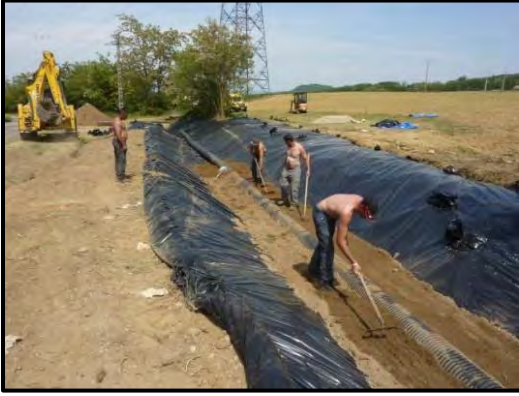
Installation de la bâche
