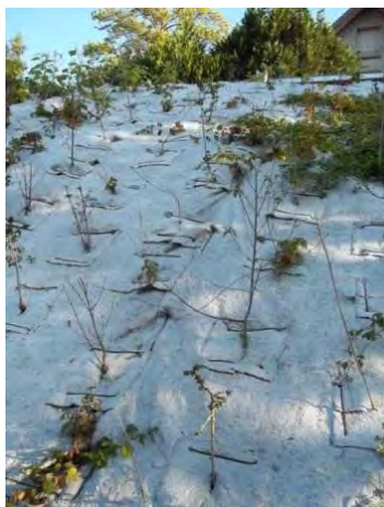
Figure 18 : Détail du géotextile de la friche industrielle des Prés de Vaux à Besançon, parcelle traitée depuis quelques mois [36]
