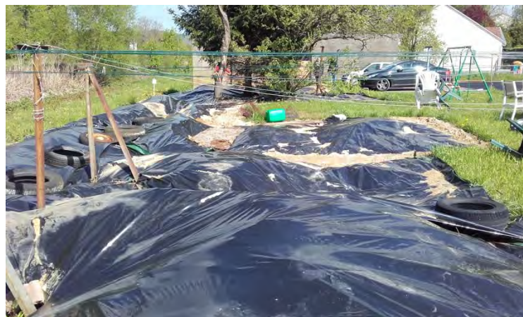
Figure 29 : Zone bâchée à Belleville Vue 1
