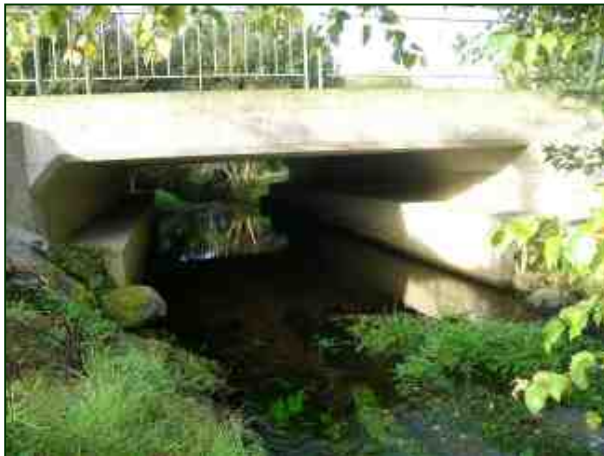
Exemples de passages à Loutre aménagés en Bretagne Banquettes en béton (trois modèles) et buse sèche (en bas à droite).
