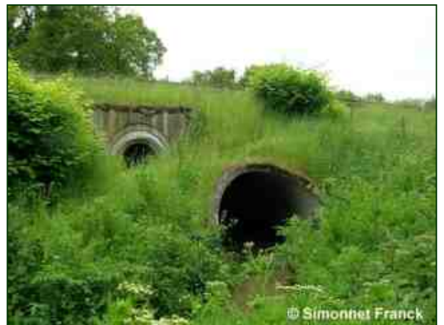
Exemples de passages à Loutre aménagés en Bretagne Banquettes en béton (trois modèles) et buse sèche (en bas à droite).
