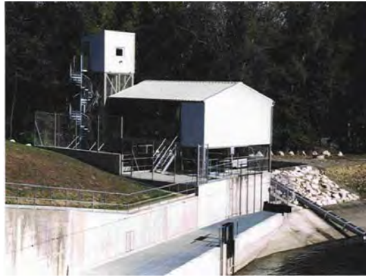
Station de piégeage-transport en montaison de Carbonne (MIGADO ©)
