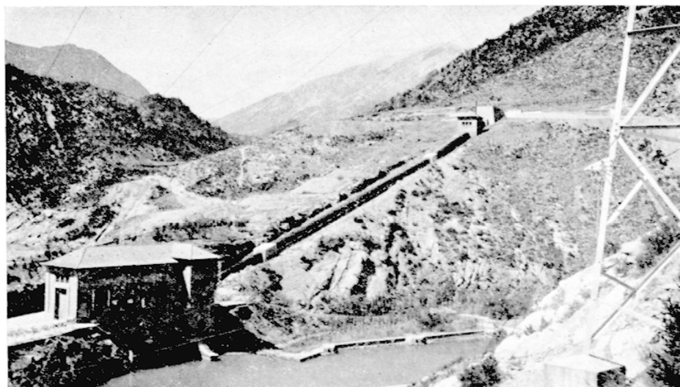
C. Conduite et centrale d'Argoné sur le rio Esera (Prov. de Huesca) : hauteur de chute : 93 m (Cliché M. Daumas).
