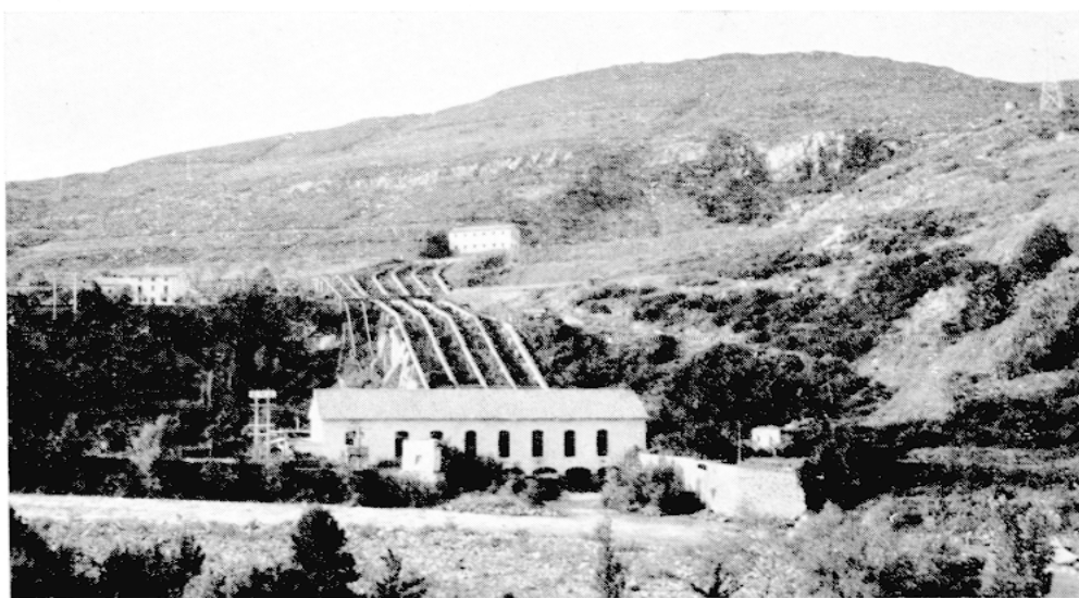
B. Conduites et centrale de Carcavilla sur le rio Gallego (Prov. de Huesca) : hauteur de chute : 62 m (Cliché M. Daumas).
