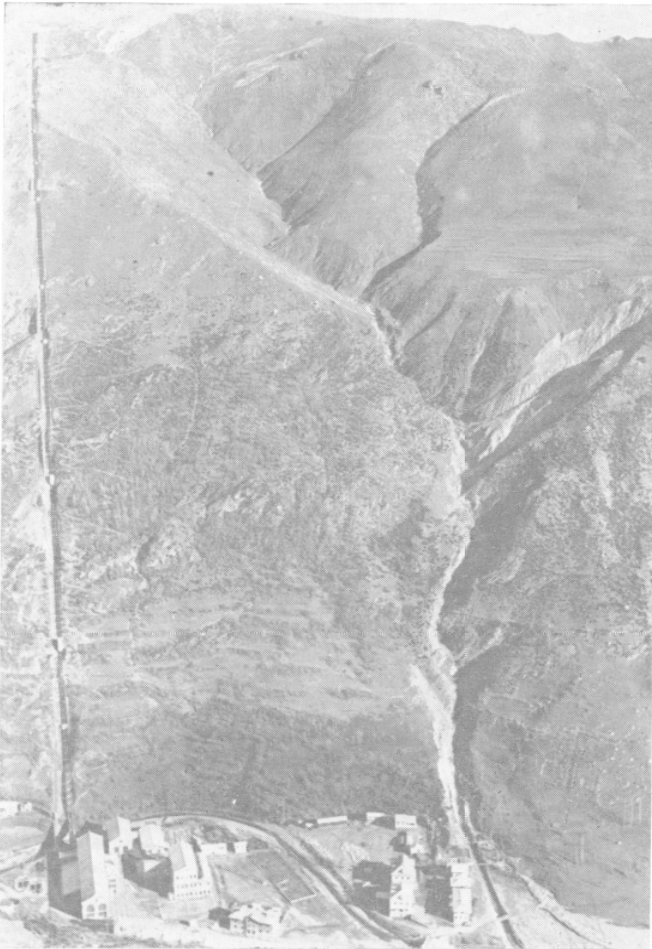
B. ( ci-contre ) Conduite et centrale de Capdella sur le haut Flamisell (Prov. de Lerida) : hauteur de chute : 830 m ( Cliché F. E. C. S. A. )
