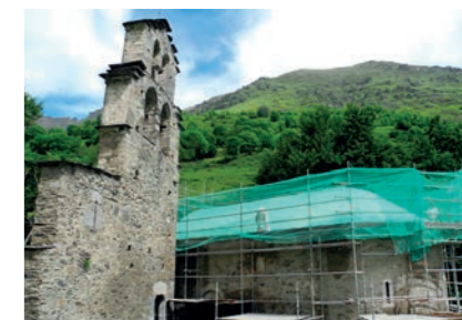
Chapelle en cours de restauration
