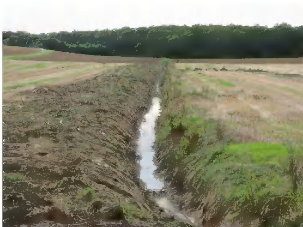
Exemple de curage avec régalinge en berge
