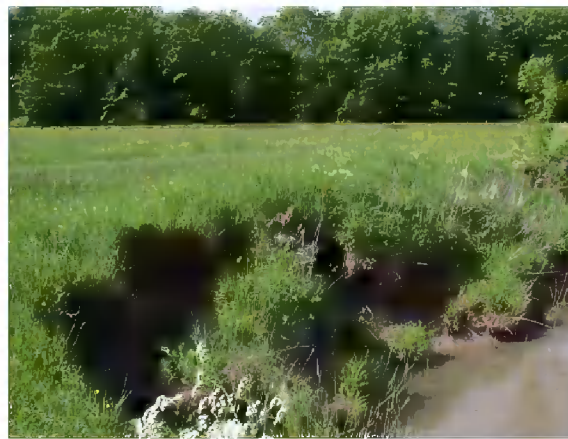
Exemple de glissement de berge
