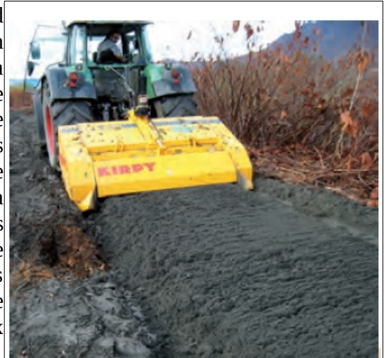
Figure 6: Passage d'un broyeur de pierres tracté sur une mince couche de terre contaminée (crédit: Mireille Boyer)
