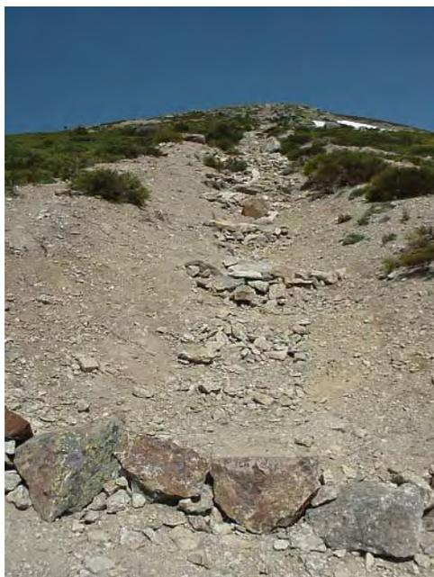
Figura 5. Barreras para controlar la erosión en cárcavas.
