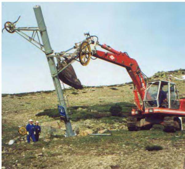
**Figura 1.** Empleo de maquinaria pesada en la demolición de las infraestructuras de la estación de esquí Valcotos.
