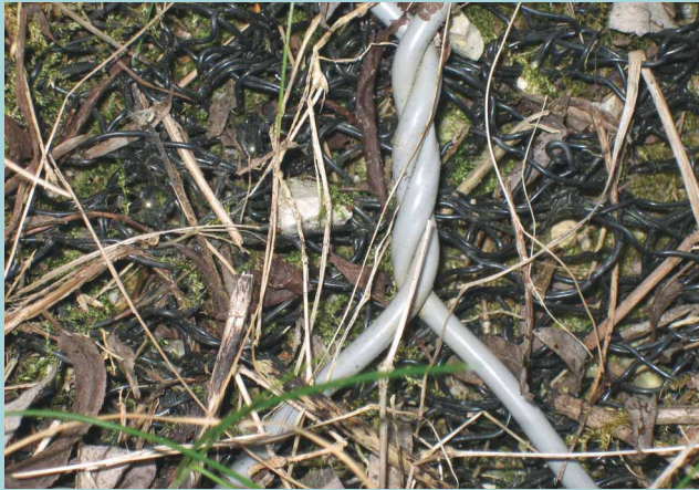
Figure 8. Exemple d'utilisation de géo-grilles plastiques pour la stabilisation de berges de cours d'eau.
