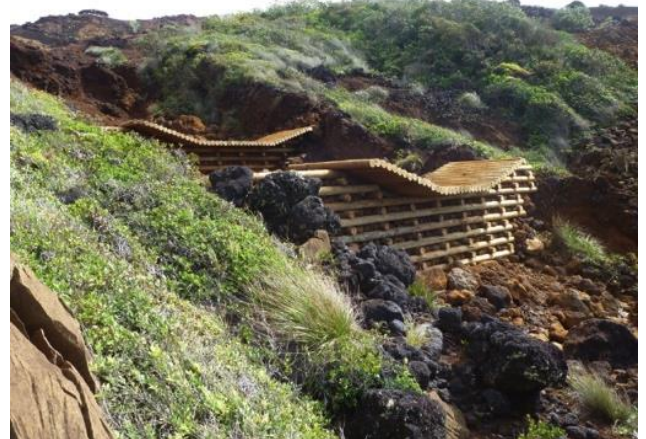
Figure 3. Ouvrage bois double-parois sur la zone Sud de Cap N'dua
