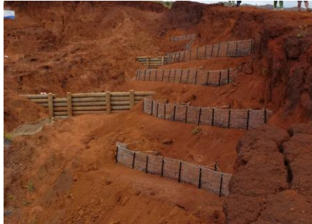
Figure 9. Banquettes grillagées en cours de construction
