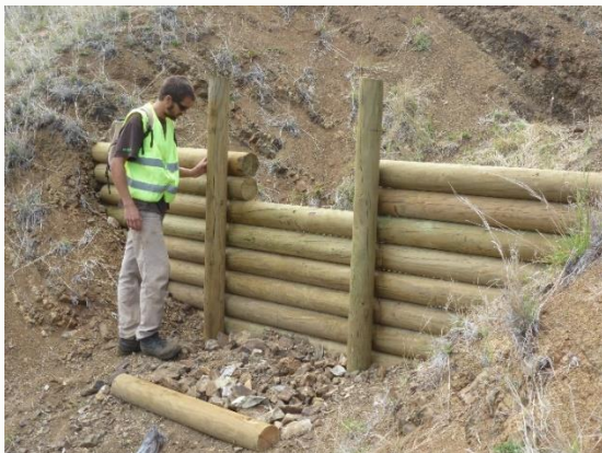
Seuil en bois simple paroi - Déva (Bourail)
