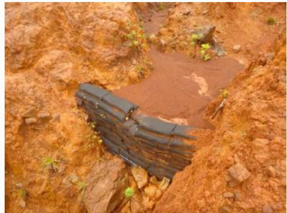
Seuil en Terralock (la coulée)
