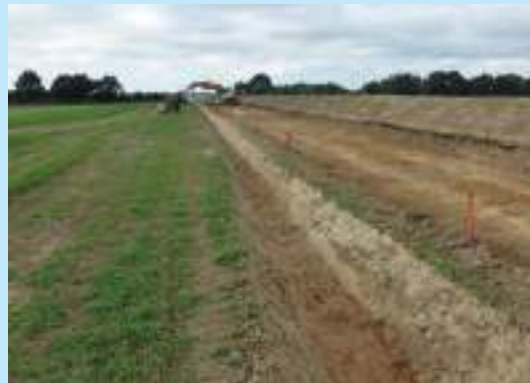
Végétalisation nécessaire lors des travaux. © Cerema
