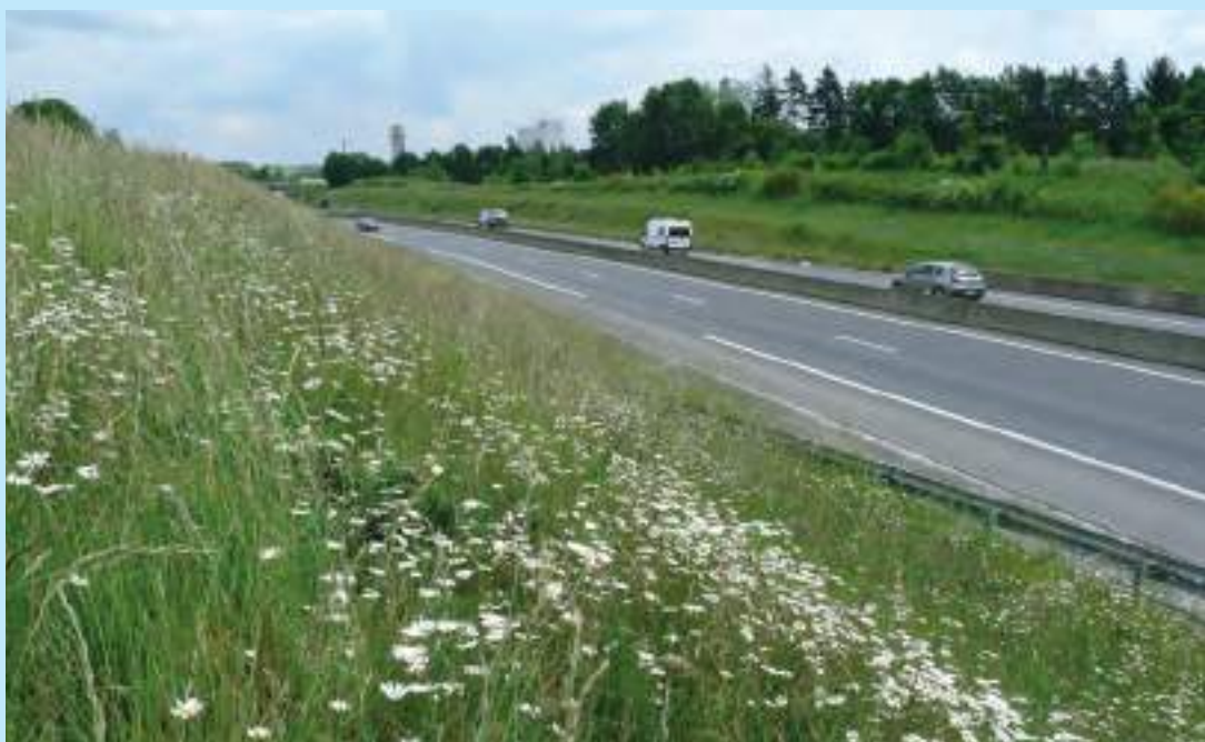
Dépendances routières fleuries. © Cerema
