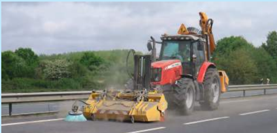
Nettoyage par balayeuse des pieds de glissière. © DIR Ouest
