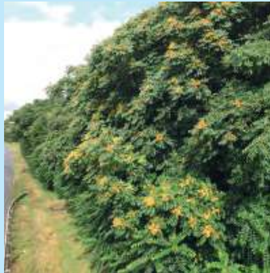
Envahissement par l'ailante d'un talus routier. © Cerema
