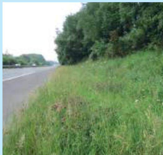
Zone ABC sur talus. © Cerema
