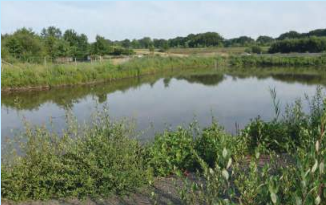
Bassin d'assainissement sur géotextile. © Cerema
