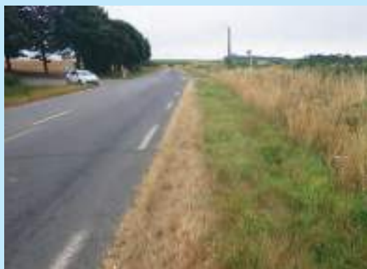
Gestion des accotements (1 passage d'engin). © Cerema
