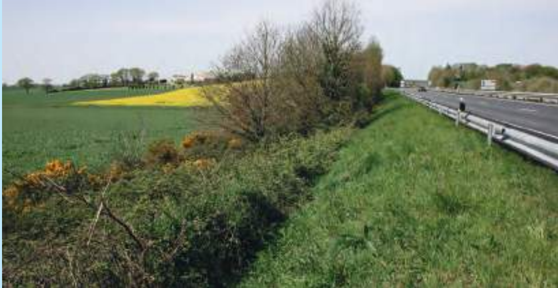
Potential des haies des dépendances routières. © Cerema
