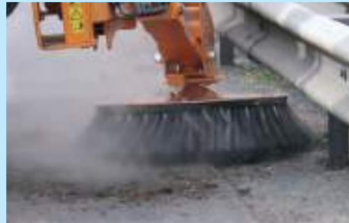
Nettoyage par brossage du terre-plein central. © Cerema
