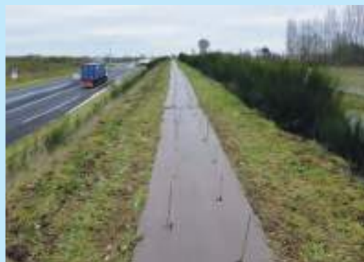
Végétalisation de talus. © Cerema
