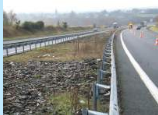
Matériaux caillouteux sur terre-plein central. © Cerema
