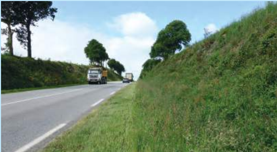
Absence de résidus herbeux après broyage-aspiration. © Cerema
