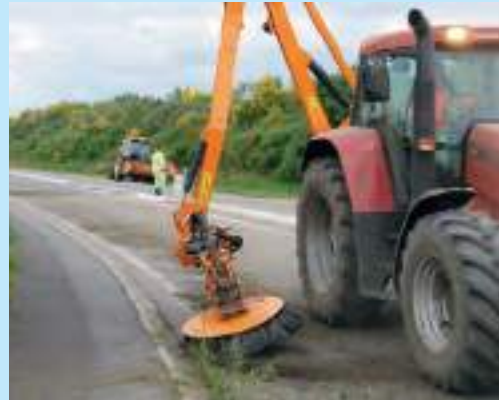
Désherbage par brossage des cunettes de trottoir. © DIR Ouest
