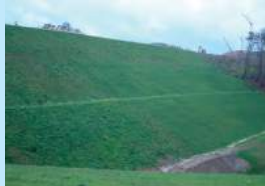
Talus enherbé. © Cerema
