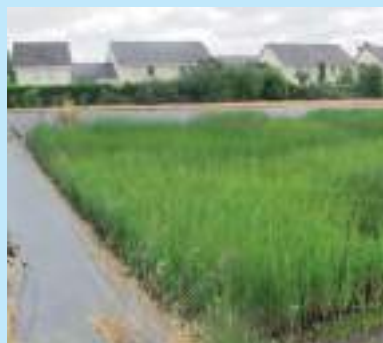
Gestion de la végétation dans un bassin d'assainissement. © Cerema
