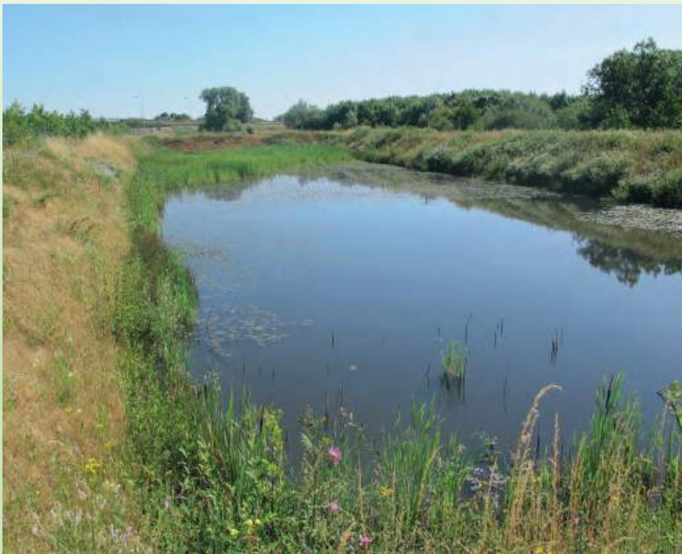
Bassin d'assainissement végétalisé. © Cerema
