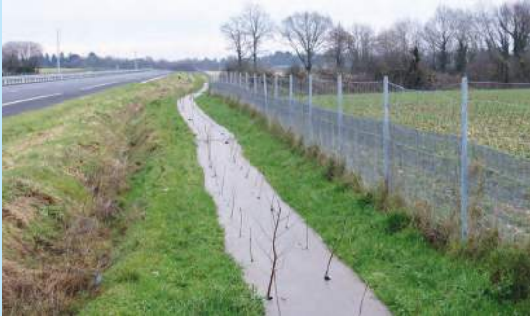
Plantation d'une haie double strate sur géotextile biodégradable. © Cerema
