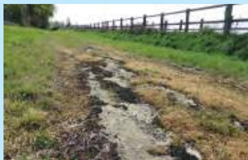
Chemin empierré sur dépendances. © Cerema
