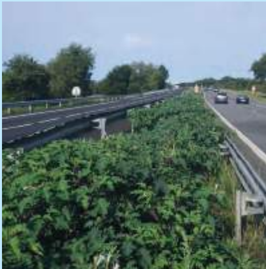
Envahissement de datura sur terre-plein central. © Cerema
