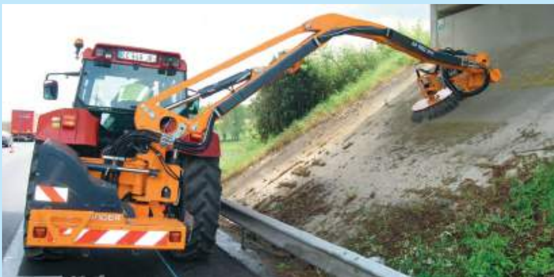
Désherbage mécanique par brossage des pieds d'ouvrage d'art. © DIR Ouest
