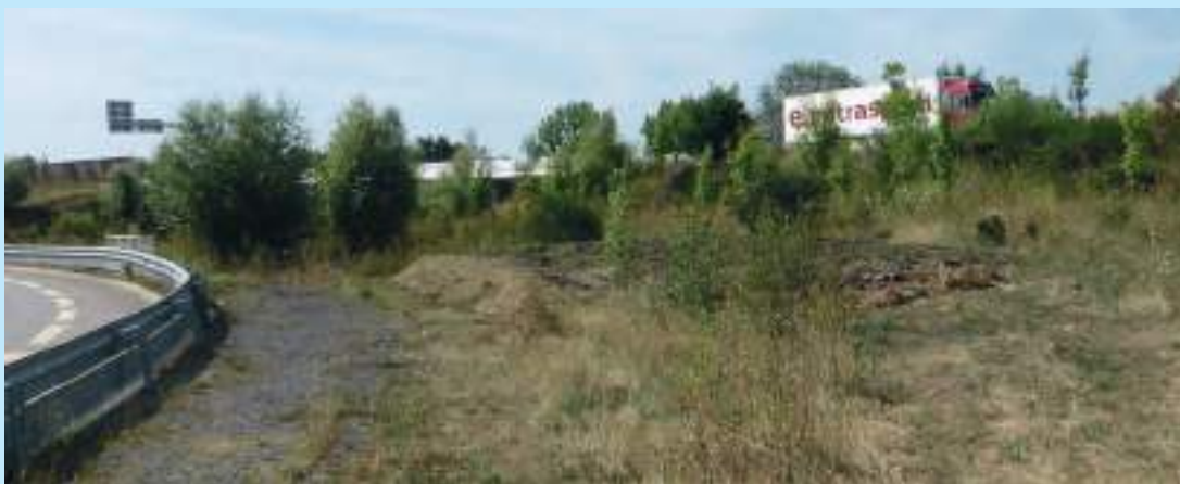
Dépôt de terre sur échangeur. © Cerema
