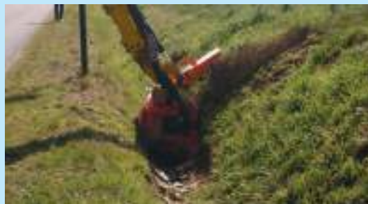
Curage à la rotocureuse. © CD Côtes d'Armor
