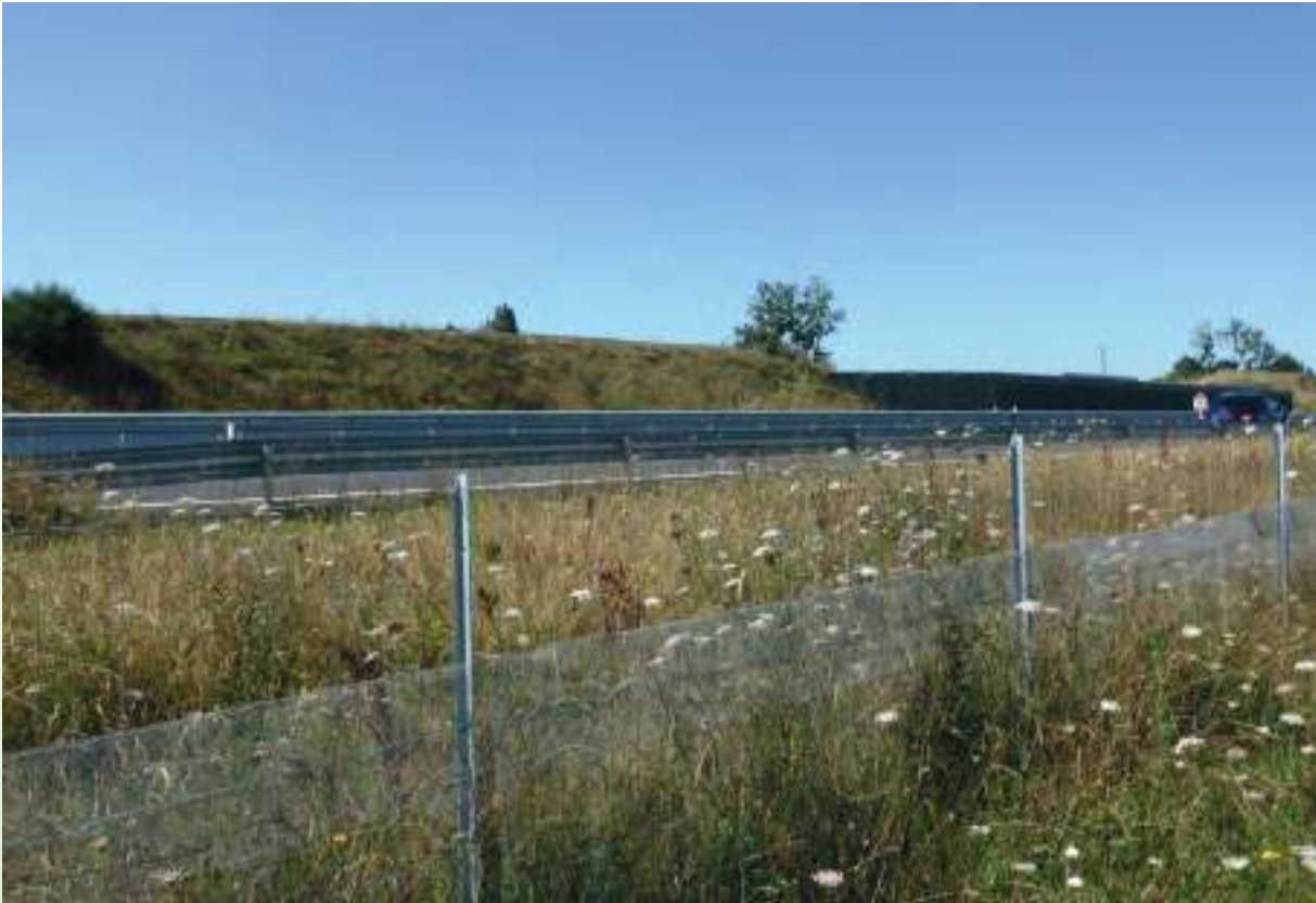
Talus couvert d'herbacées et d'arbustes. © Cerema
