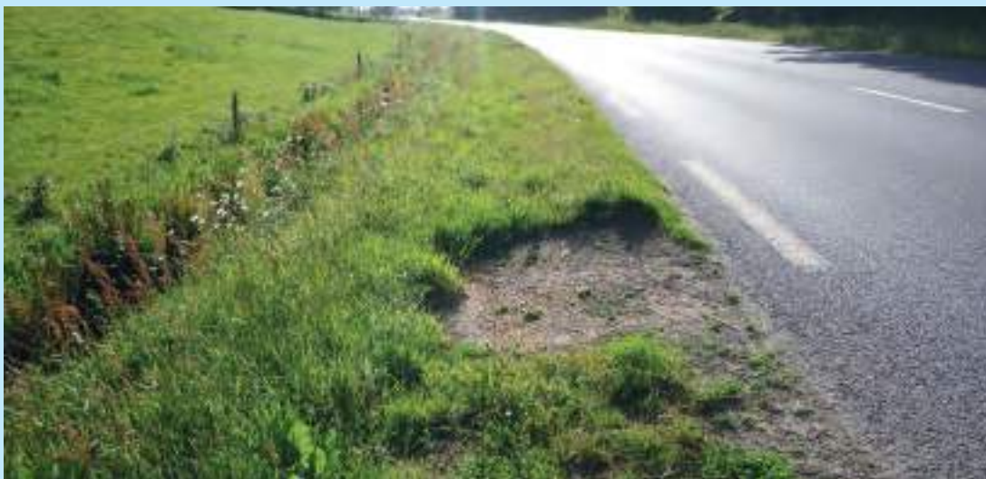
Saignée d'accotement pour gestion des eaux. © Cerema
