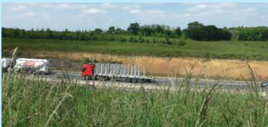
Talus routier non végétalisé. © Cerema
