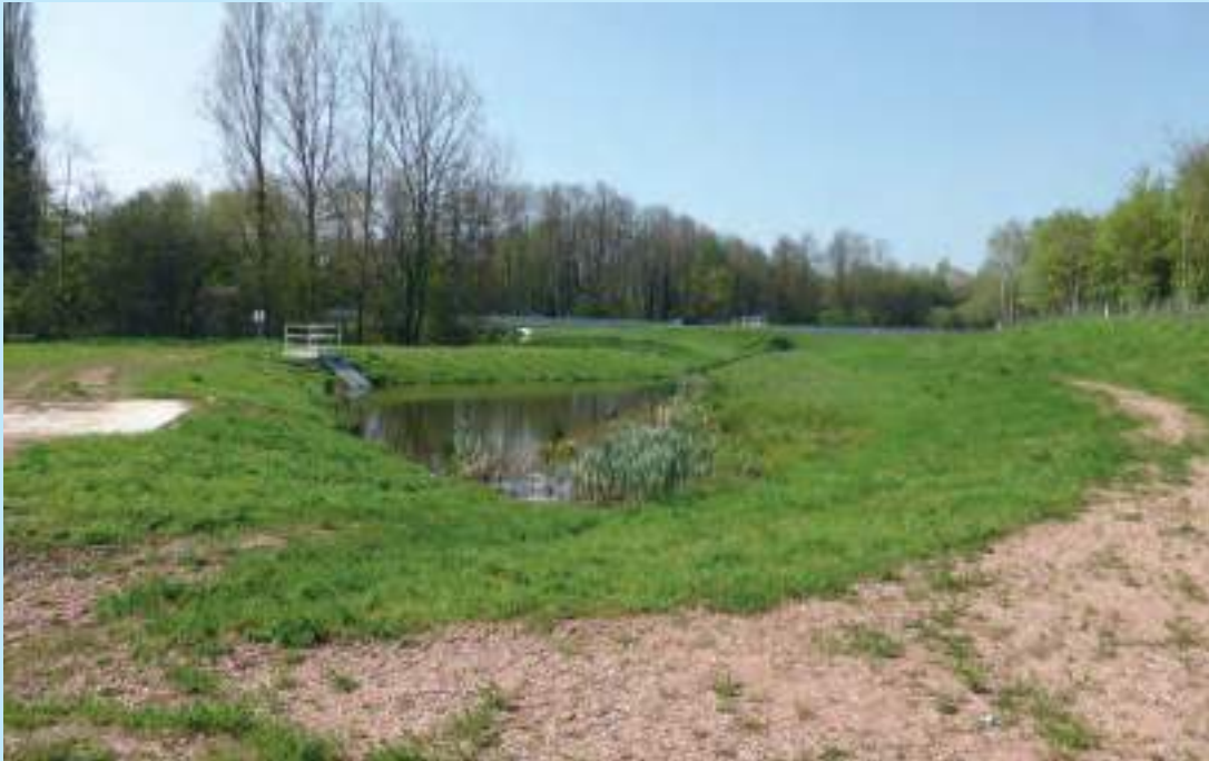
Bassin d'assainissement en terre. © Cerema
