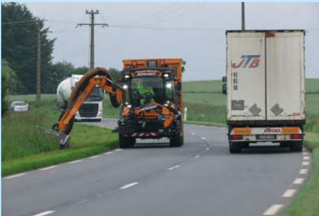
Fauchage-aspiration des accotements en courbe avec système VSV Noremot. © Cerema
