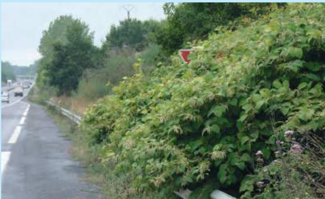
Massif de renouées devant un panneau de signalisation. © Cerema
