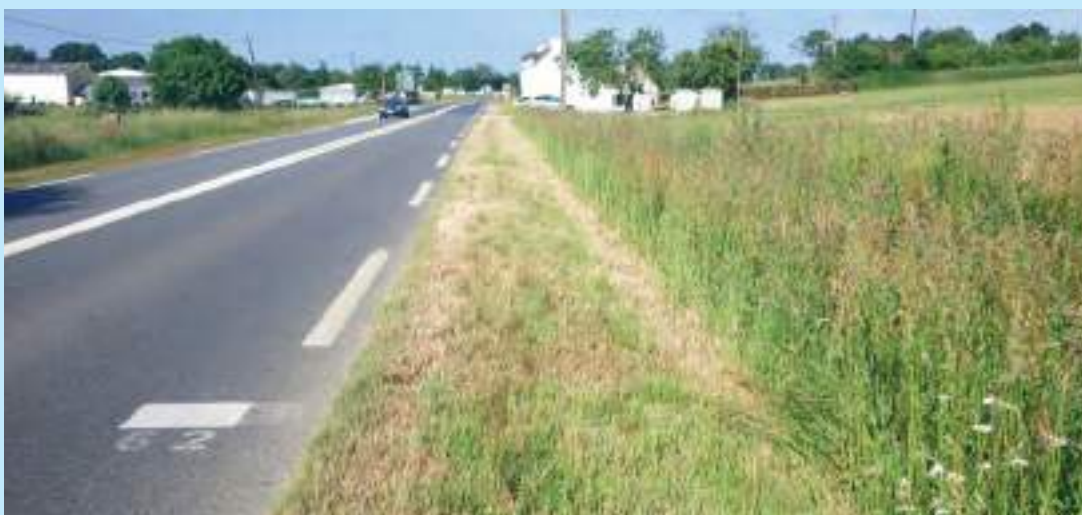
Rendu après passage à 12 cm sur une largeur de rotor. © Cerema
