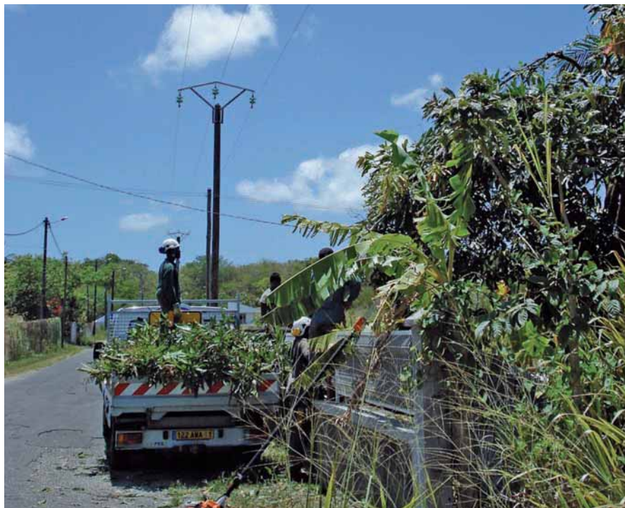
Chantier EDF à Bonne-Terre
