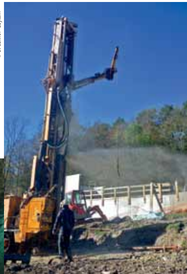
Une ressource en eau exploitée de tout temps et avec des moyens variables : la réalisation d'un nouveau forage pour l'eau potable, ci-dessus, le captage d'un drain karstique, ci-contre.
