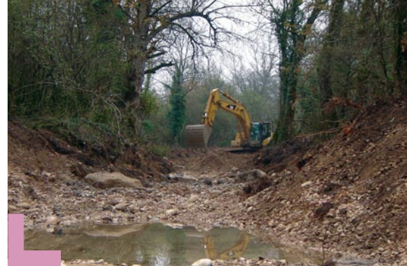
Curage profond dans le plancher de galets.
