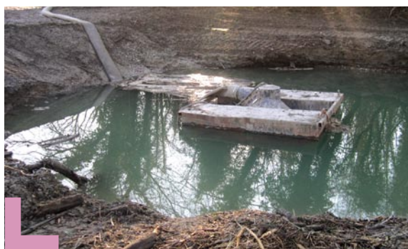
L'utilisation d'un batardeau et d'une pompe permet de maintenir le chenal à sec durant l'intervention. Ce système a l'avantage de minimiser la turbidité dans le chenal principal.
