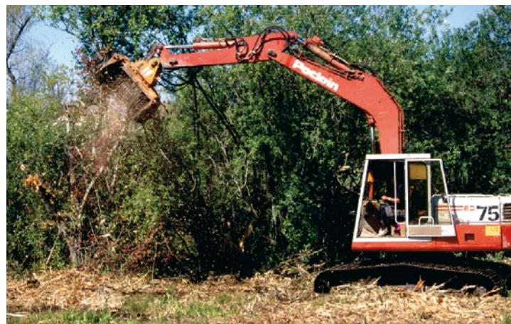
Broyage à l'aide d'une pelle mécanique
