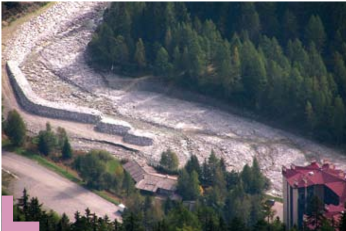
Aménagement réalisé à la confluence d'Argentière pour améliorer le transit des matériaux entre l'affluent et l'Arve.
