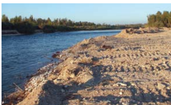
Travaux de remobilisation sur la rivière d'Ain.
