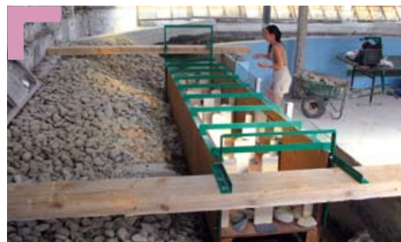
Montage du fluvarium de la Gare des ramières.
