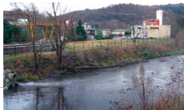
Tous les contrats de rivière travaillent au perfectionnement de leur réseau d'équipement d'assainissement collectif. Ici une station d'épuration sur le Gier.
