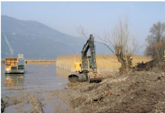
Sur les rives du lac du Bourget, engraissement contre les fascines avec des matériaux issus du décapage terrestre.
