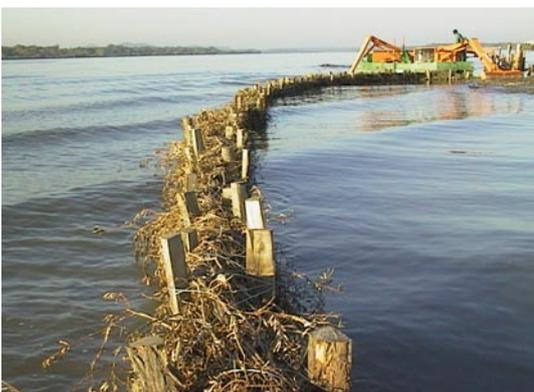
Intervenir en milieu aquatique suppose l'utilisation d'engins spécifiques : pelle flottante, compresseur disposé sur une barge... peu d'entreprises disposent de ce matériel, et leur calendrier est souvent rempli longtemps avant...
