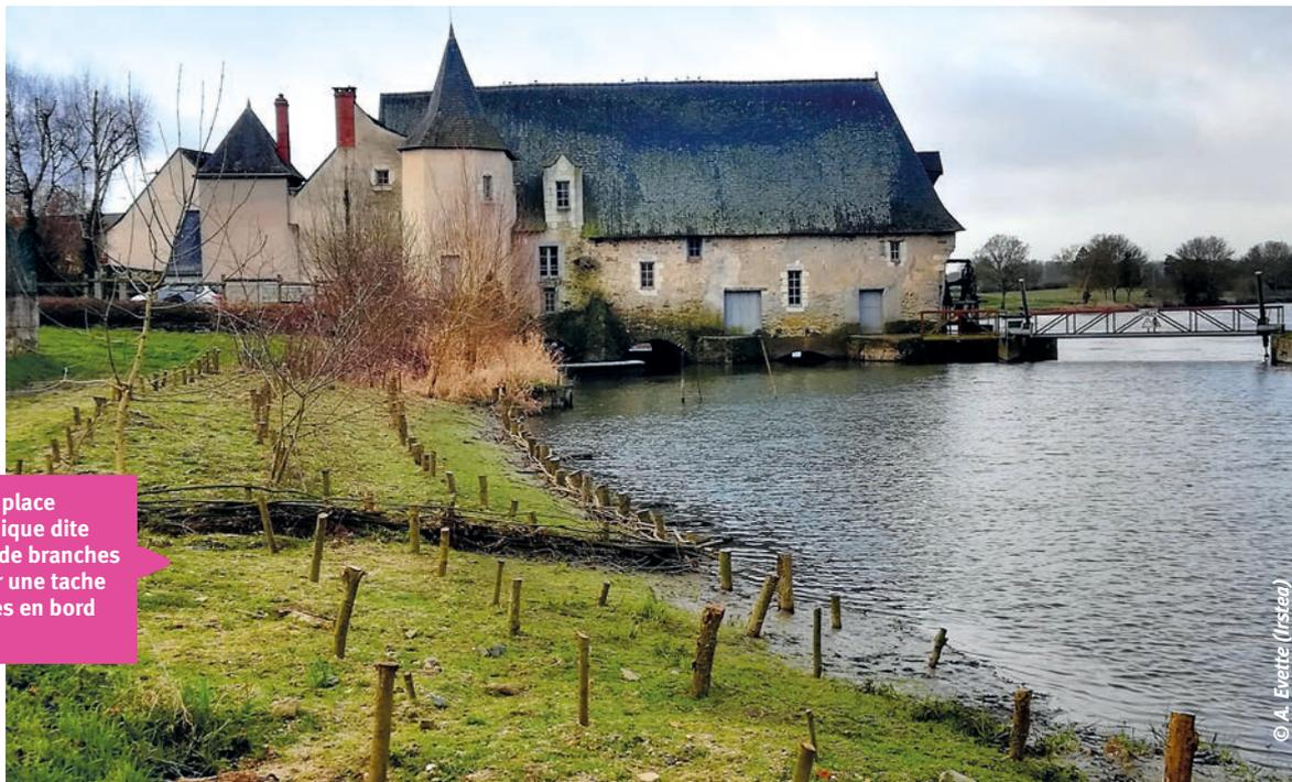
➊ Mise en place de la technique dite de couche de branches à rejets sur une tache de renouées en bord de rivière.
