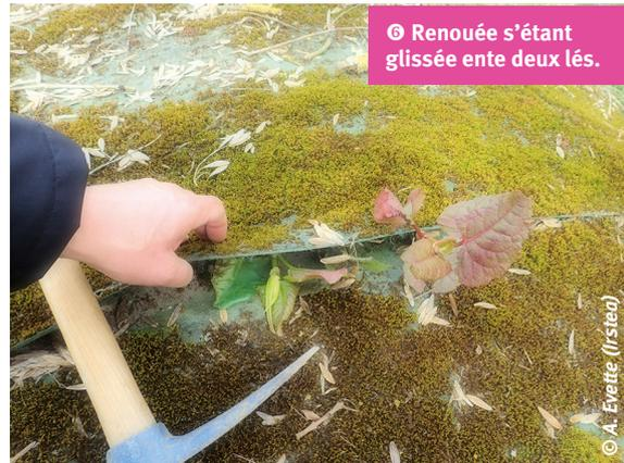
De même sur ces grandes taches, des contacts avec des maçonneries, arbres ou autres singularités viennent fréquemment constituer des points de faiblesse.
