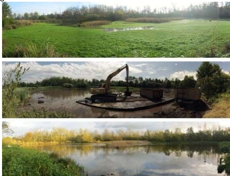
Figure 6 : Avant-pendant-après chantier d'arrachage mécanique en 2013 – Before-during-after mechanical digging in 2013
