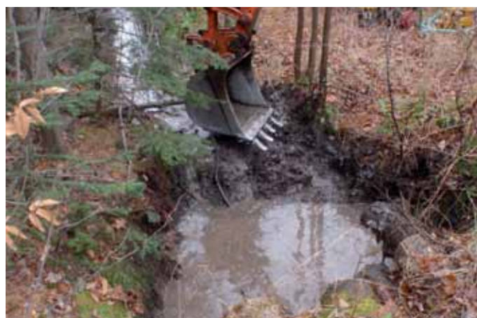
Figure 23. Barrage de tourbe en cours de construction à la tourbière de la Grande plée Bleue (Québec).
