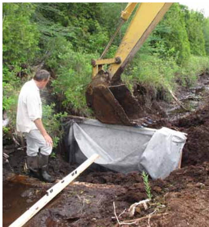
Figure 22. Installation d'un panneau de bois recouvert de géotextile (tourbière de Bic – Saint-Fabien, Québec).
