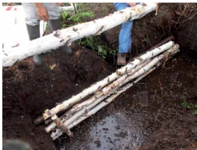
Figure 25. Barrage en rondins de bois – approche déconseillée.
