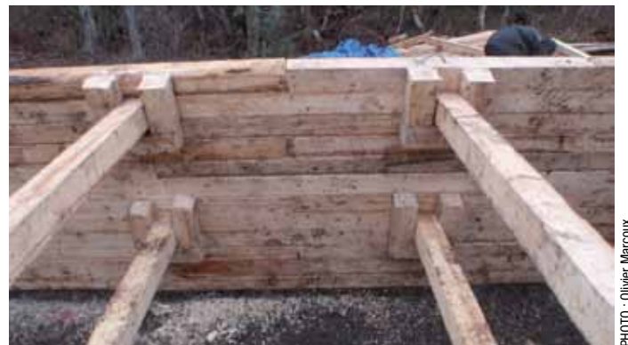
Figure 31. Structures en U pour stabiliser les travers.
