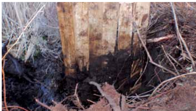
Figure 26. Essai de la technique de palissade verticale par enfoncement individuel; constatation des ouvertures entre les madriers.
